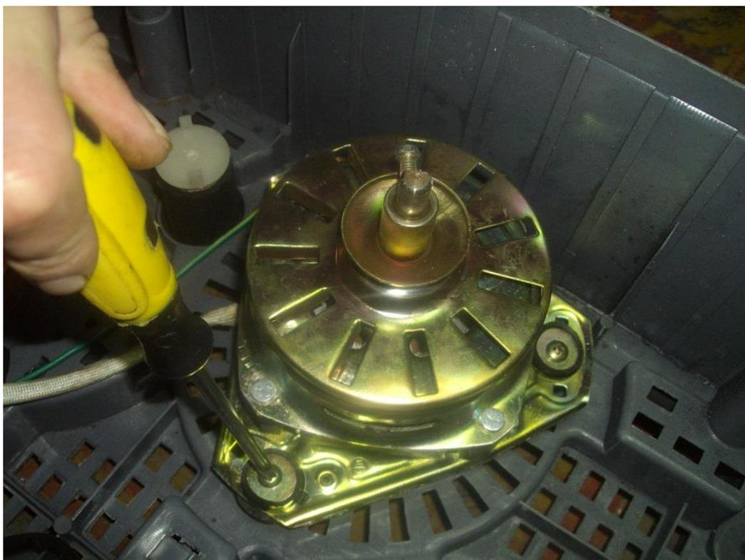
8. Выкрутите винт (не полностью) крепления вентилятора двигателя, затем снимите вентилятор;
